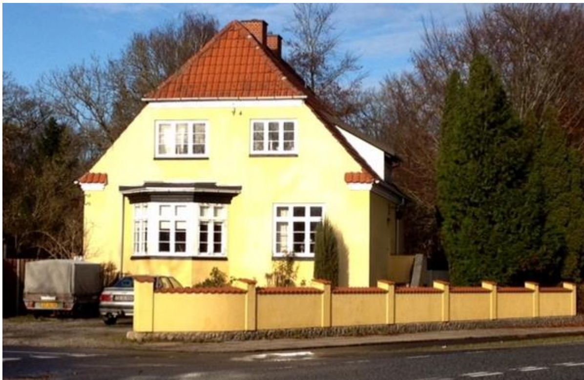
Diplom tildeltes ejendommen Egevangs Allé 8 som påskønnelse af ejernes indsats for fin bygningsvedligeholdelse med respekt for den ældre byggestil.
