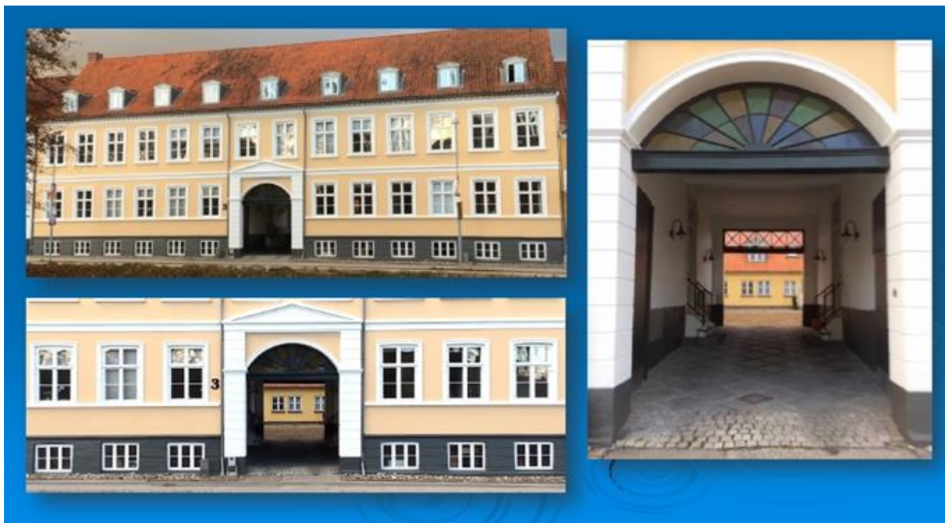
Priorgade 3. Der er gennemført en smuk ydre istandsættelse af det markante byhus. Formpudsede gesimser, bånd og indfatninger om de gamle vinduer er istandsat. Portrummet og fronten mod gaden har stor herlighedsværdi.
