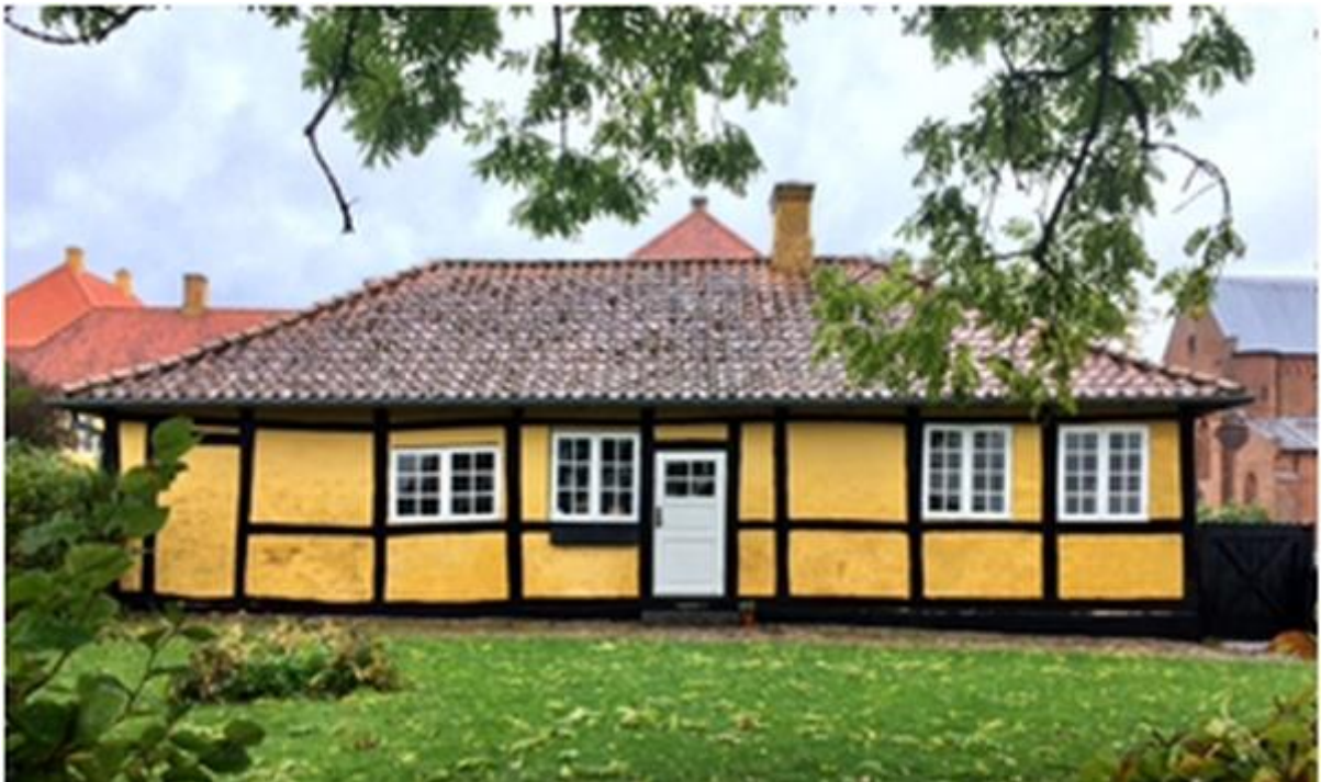
Udhuset ved Molbechs Hus. Brugere: Sara Henriksen og Ulrich Martin.
